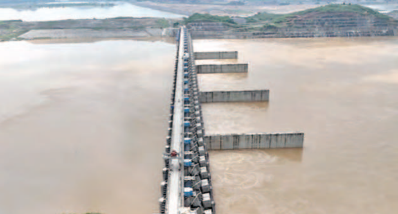
శనివారం పోలవరం ప్రాజెక్టుపై భారీగా చేరిన గోదావరి వరద
